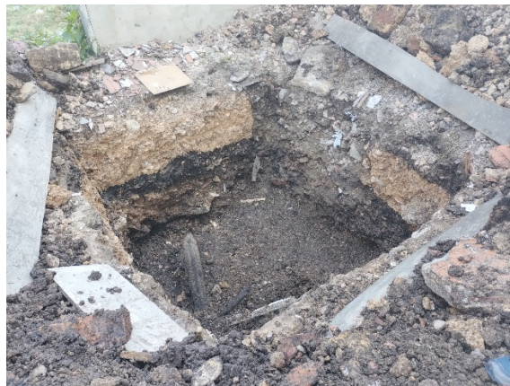
Fotografia N° 4 . Excavación para el nuevo pozo séptico en las coordenadas planas Origen Unico Nacional CTM 12 N: 2079438 y E: 4864690 a 2556 msnm.
